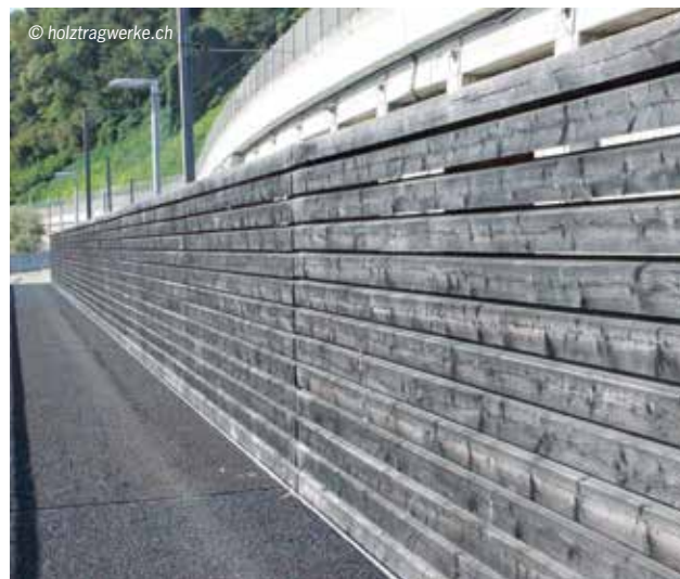
Stato attuale passerella
