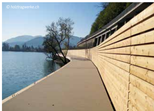
Montaggio completato, manca ancora la balaustra lato lago – nov. 2011
