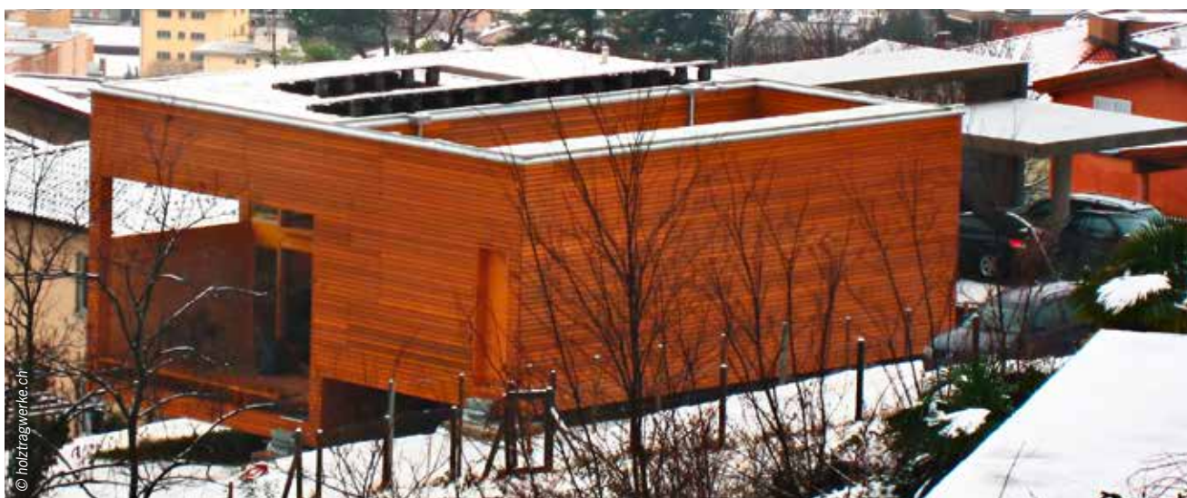
Edificio a Pregassona - 2007
