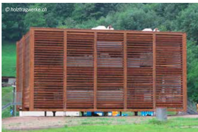
Laboratorio di analisi a Olivone 2007 - facciata vetrata
