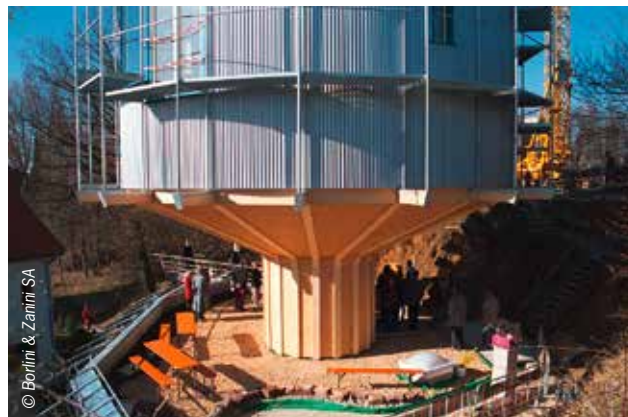
Impronta al suolo e fondazione Heliotrop - Freiburg D - 2007
