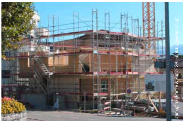
Avanzamento montaggio struttura legno al 16.10.2021
