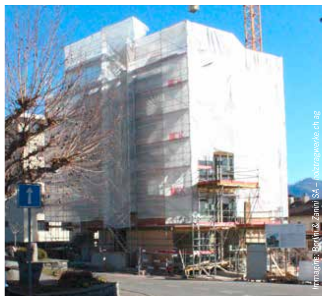
Avanzamento montaggio struttura legno al 14.01.2022
