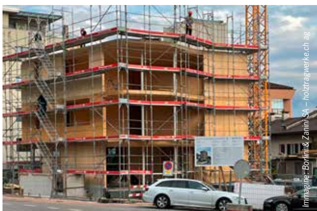
Avanzamento montaggio struttura legno al 25.10.2021
