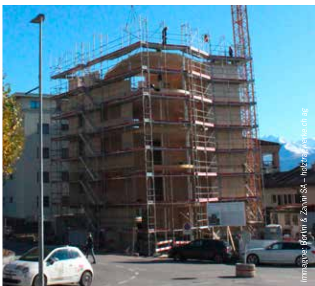
Avanzamento montaggio struttura legno al 05.11.2021
