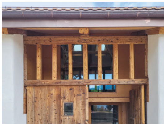
Figura 15 Legno massiccio riutilizzato a Corgémont.
