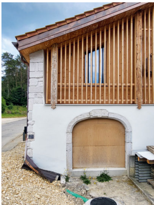
Figura 16 Legno massiccio riutilizzato in combinazione con un nuovo progetto di facciata a Corgémont.
