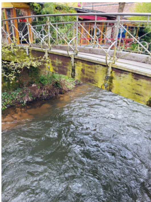
Figura 9 Prodotti di legno, quale legno lamellare incollato, già esposti a forti sollecitazioni, dovute alle condizioni climatiche, sono da escludere per un riutilizzo quali opere con funzioni di sostegno.
